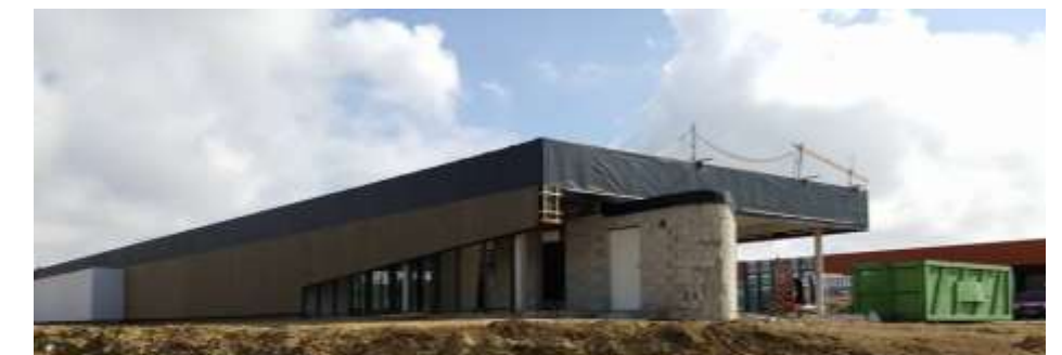
Le chantier du futur Centre de Loisirs Intercommunal.
