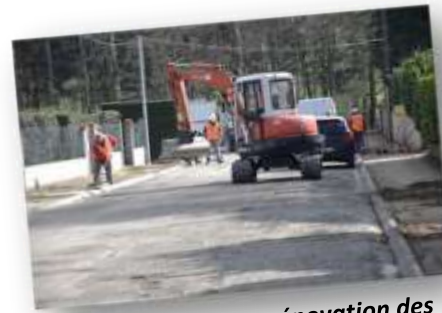
Moulin de l'Aygue – rénovation des trottoirs et de la couche de roulement.
