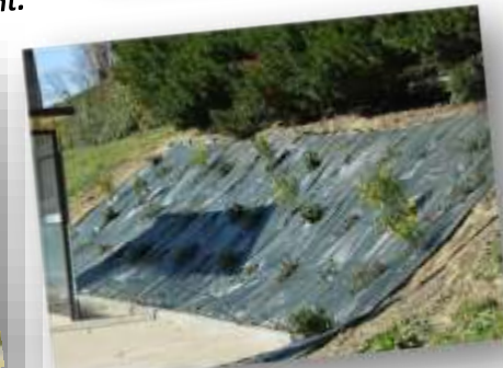
Aménagement du talus avenue Tolosane
