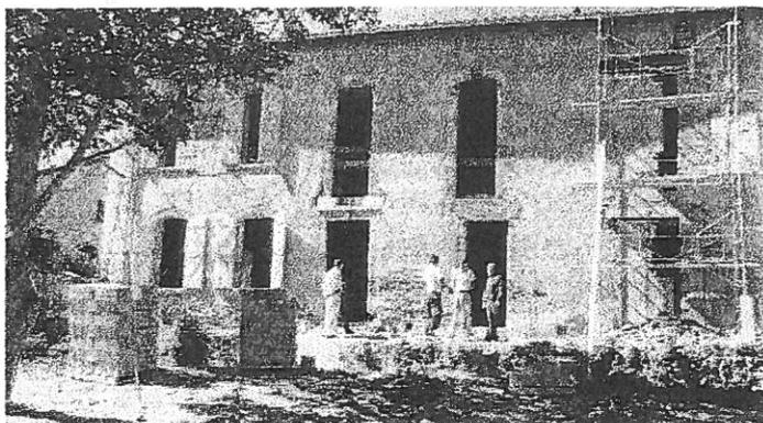
Le gros œuvre s'achève au rythme prévu par l'architecte. Les planchers et les ouvertures sont terminés. Les façades sont prêtes à recevoir les enduits. La pose des menuiseries est prévue au début du mois d'octobre.
