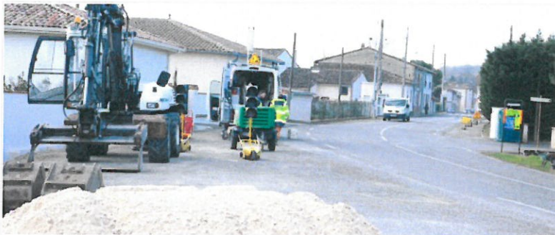
Hier matin, mardi 13 janvier, l'entreprise en charge des travaux assurait le balisage du chantier le long de la rue de la République. (Crédit photo : Paul Halbedel)
